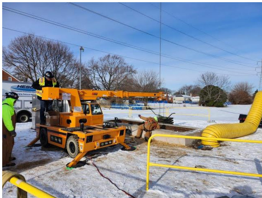
CS-5 Cylinder Repair
